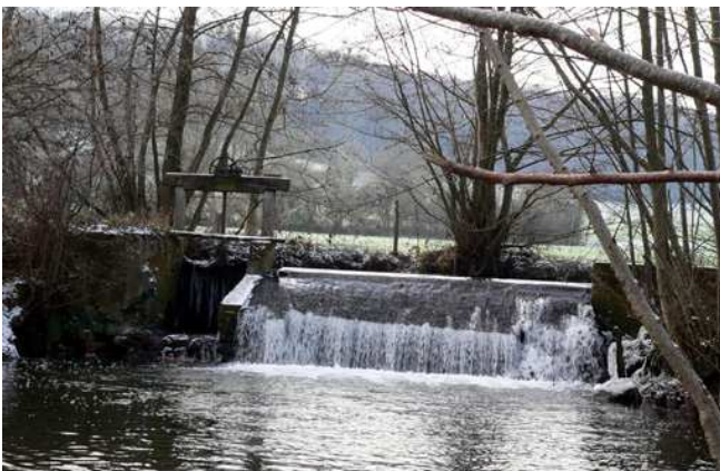
Vannage et seuil sur la Commeauche à Maison-Maugis (totalement infranchissable)
